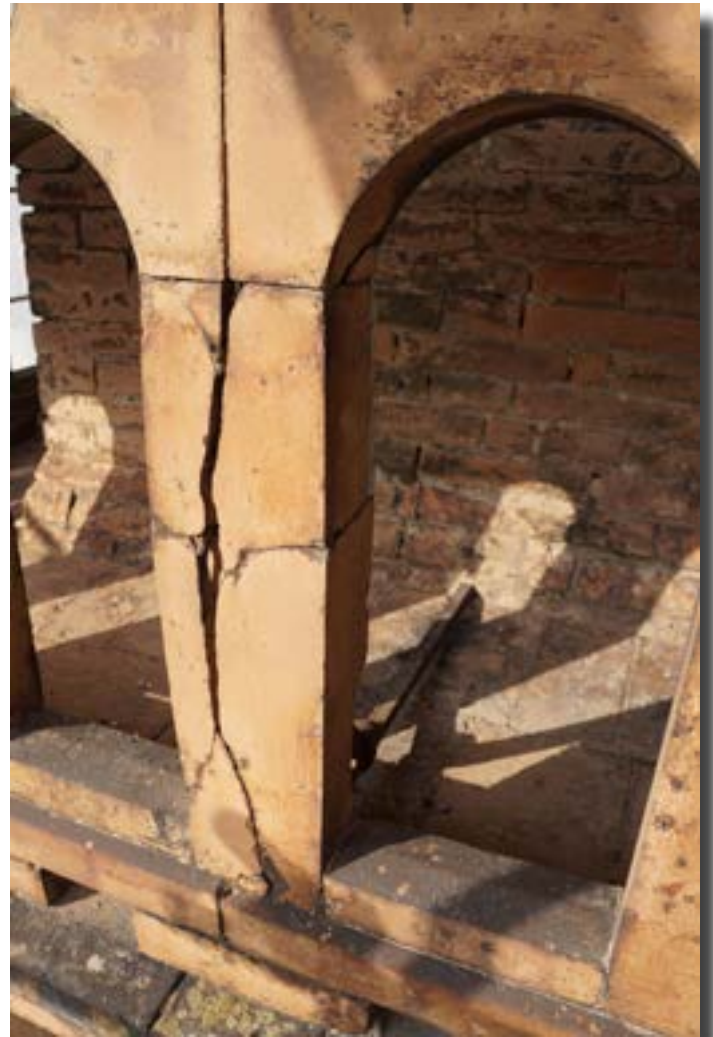
Degrado strutturale ed architettonico del parapetto sommitale del campanile da consolidare e restaurare
