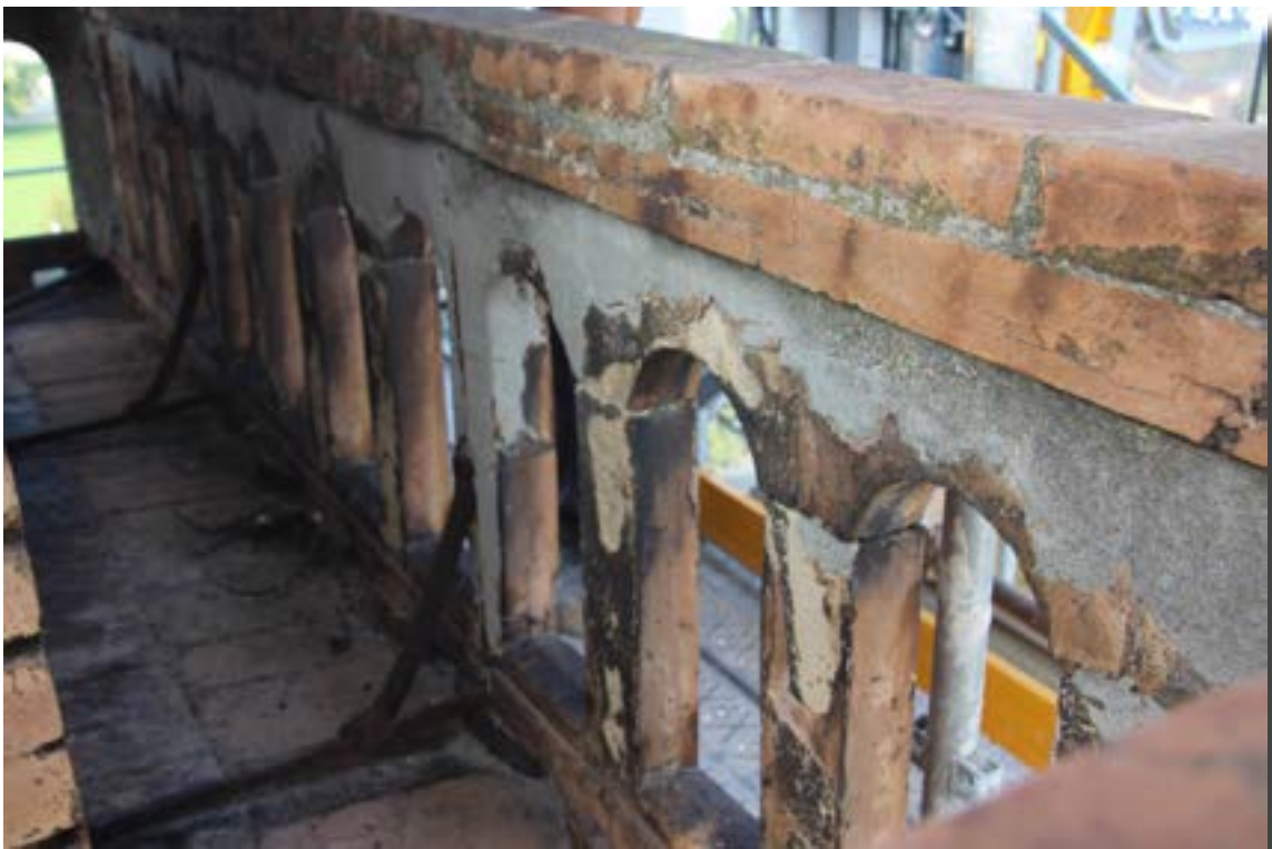
Degrado strutturale ed architettonico del parapetto sommitale del campanile da consolidare e restaurare
