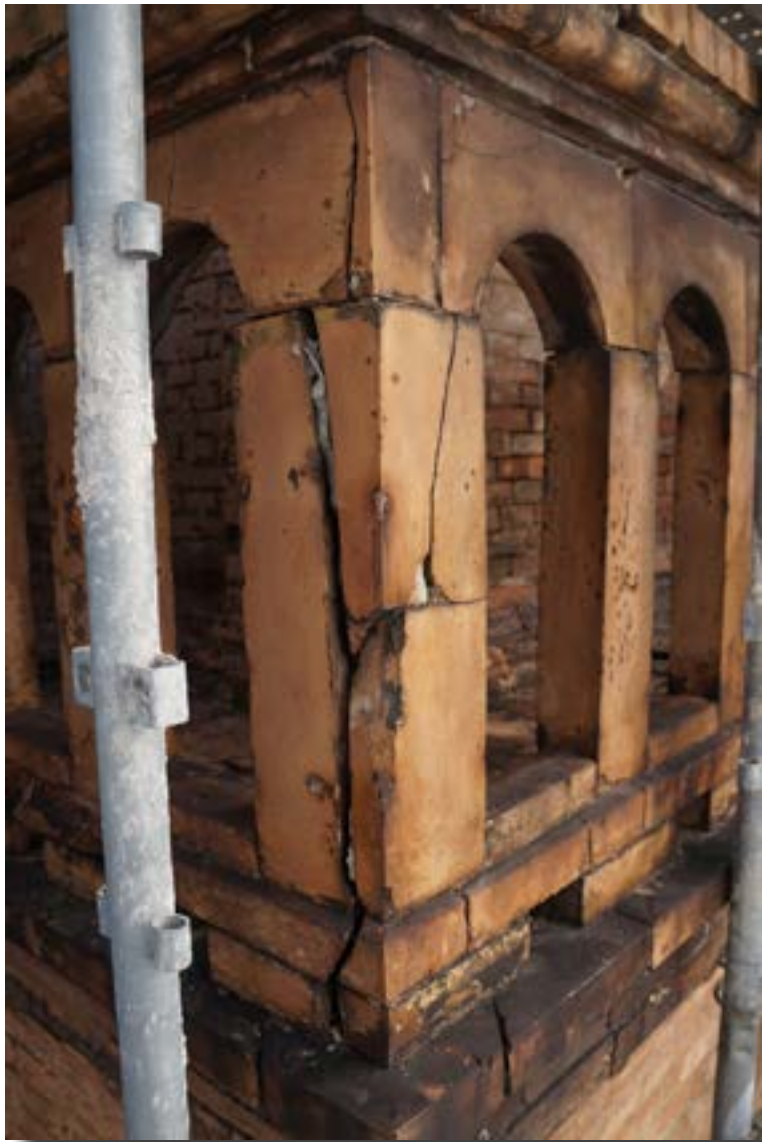
Degrado strutturale ed architettonico del parapetto sommitale del campanile da consolidare e restaurare
