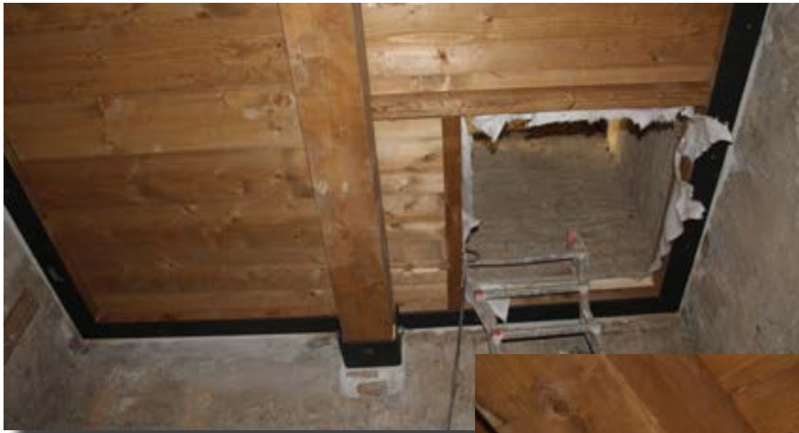
Nuovi impalcati interni in trave e tavolato di legno
